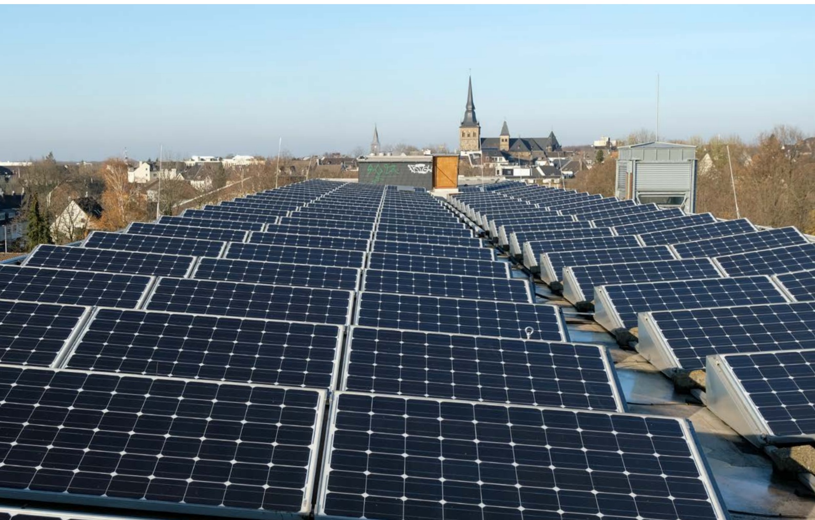
Abb. 12: Viele öffentliche Gebäude in Ratingen wie hier das CFvW-Gymnasium schmückt bereits eine PV-Anlage (Bild: Stadt Ratingen)
