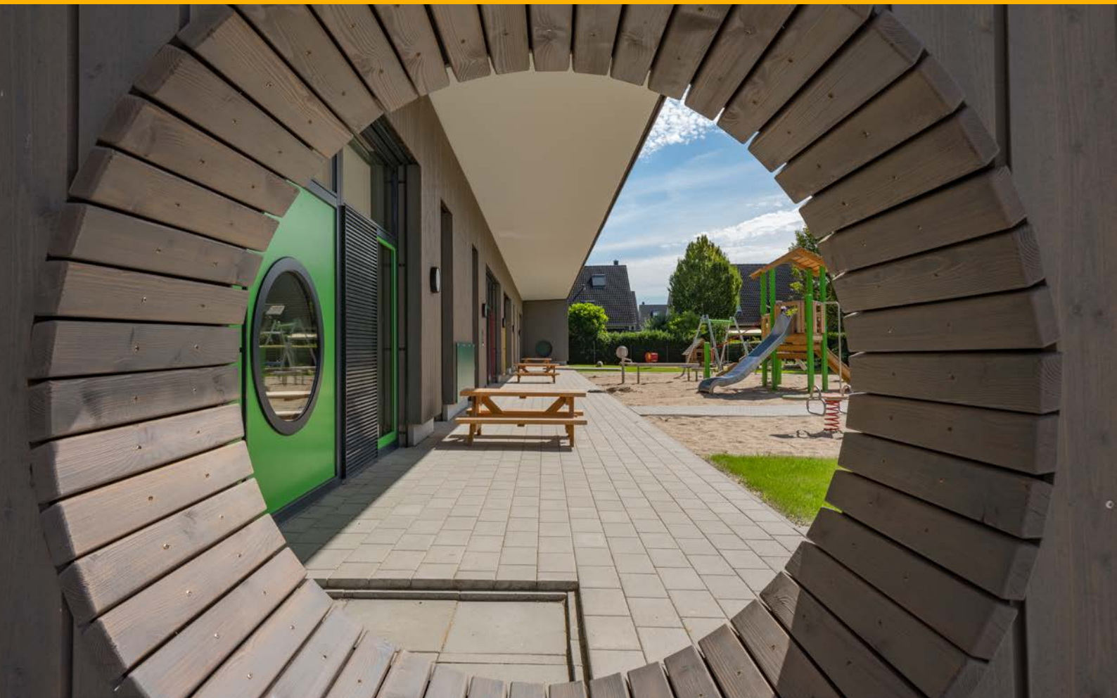
Abb. 32: Das Zentrale Gebäudemanagement setzt beim Bauen auf strenge Nachhaltigkeitskriterien (© Stadt Krefeld, Zentrales Gebäudemanagement; Sven Fennema)
