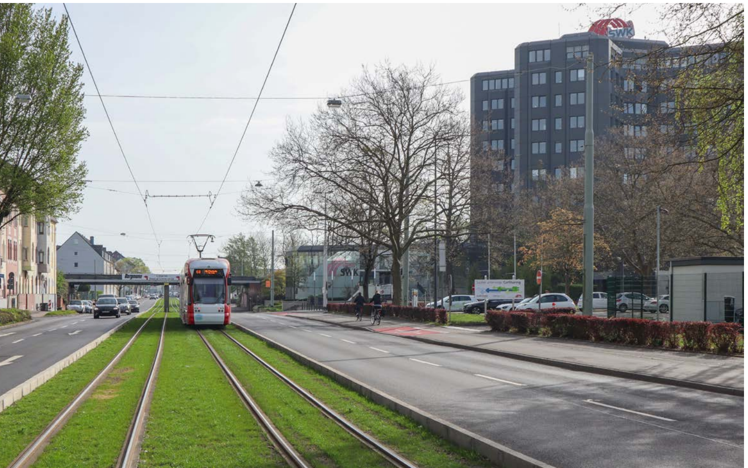
Abb. 13: Rasengleis auf der St. Töniser Straße (© SWK AG)
