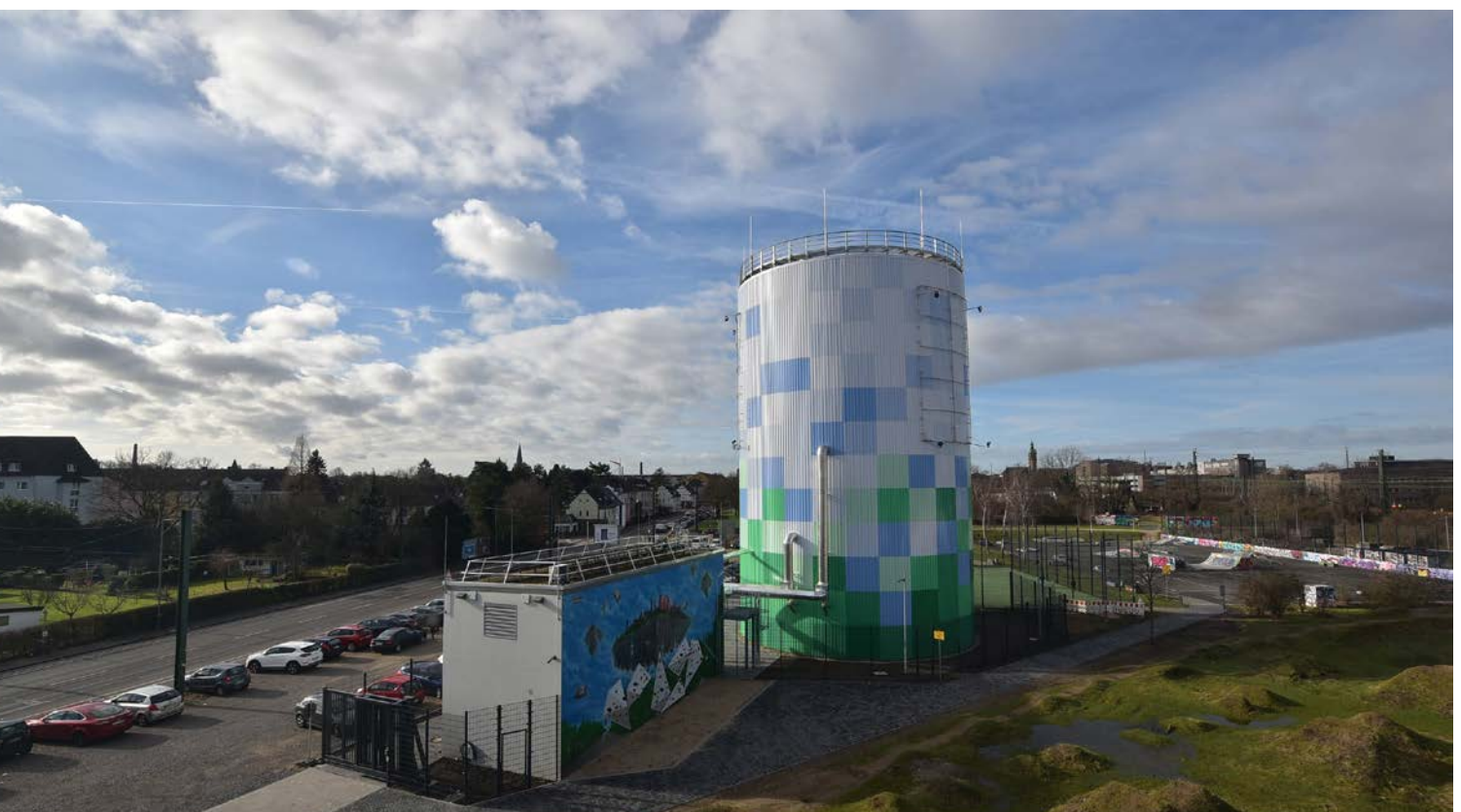
Abb. 10: Wärmespeicher (© SWK AG)
