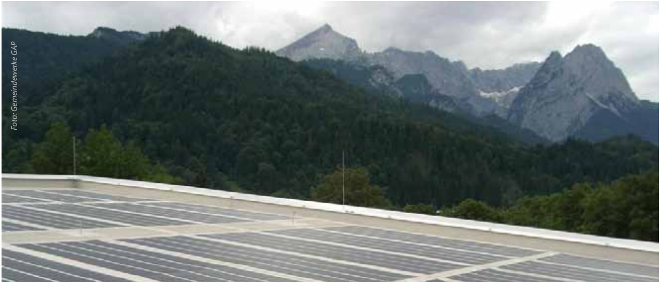
Photovoltaik-Anlage auf dem Alpspitzhallenbad
